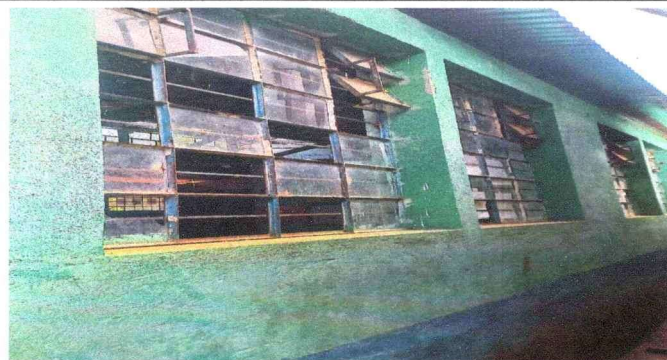
Foto 5: SUSTITUCION DE VIDRIOS EN MAL ESTADO EN AULAS
