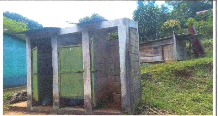
Foto 4: MANTENIMIENTOS DE BAÑOS
