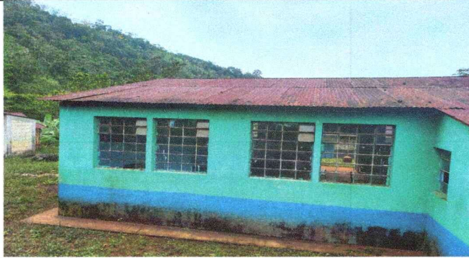
Foto1: SUSTITUCION DE LAMINAS EN AULAS
