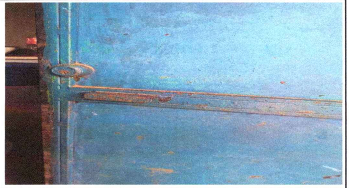
Foto 2: SUSTITUCION DE CHAPA DE PUERTA
